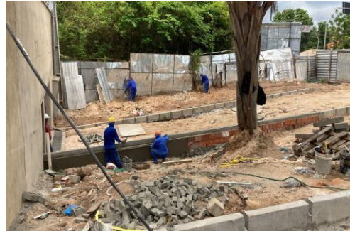
(b) Etapa de Construção do Edifício
