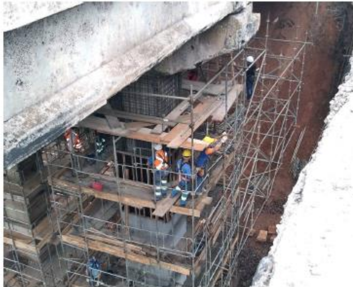
Figura 8 – Execução da Armadura de Reforço
