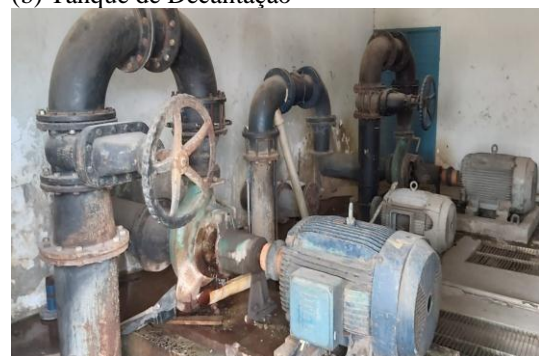
(d) Casa de Bombas
