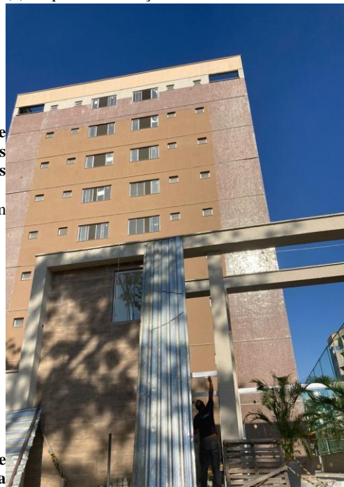
(c) Edifício Concluído
