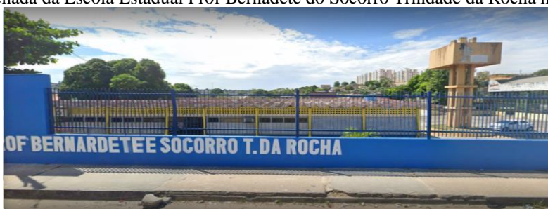
Figura 1– Fachada da Escola Estadual Prof Bernadete do Socorro Trindade da Rocha no ano de 2021.
