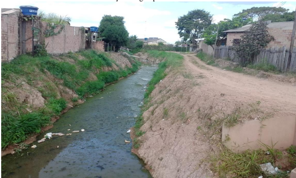
Figura 10 - Um dos afluentes do igarapé Tancredo Neves, com lixo e águas servidas, no bairro Lagoinha, chama a atenção a pequena distância do acesso de veículos em relação ao igarapé.
