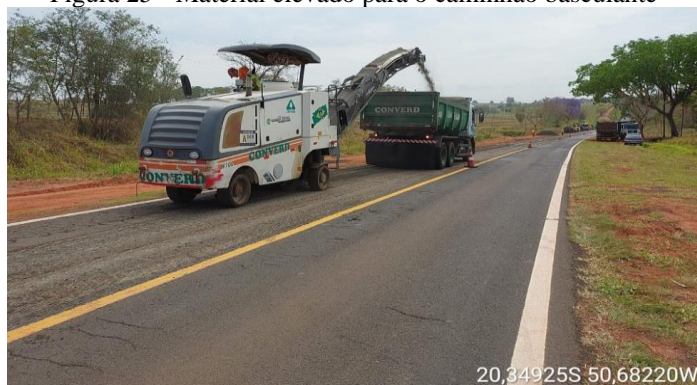
Figura 25 - Material elevado para o caminhão basculante
