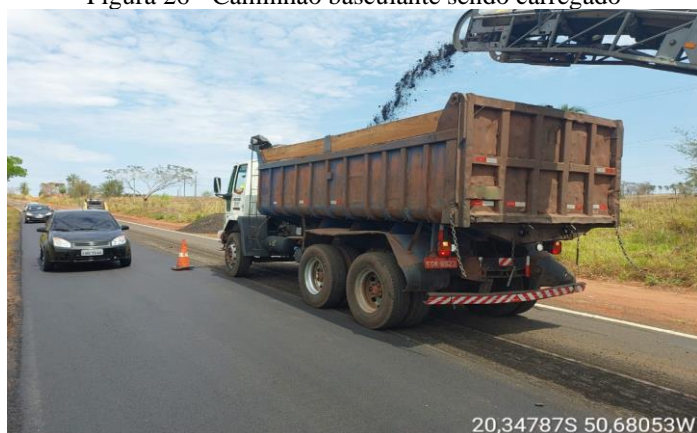
Figura 26 - Caminhão basculante sendo carregado
