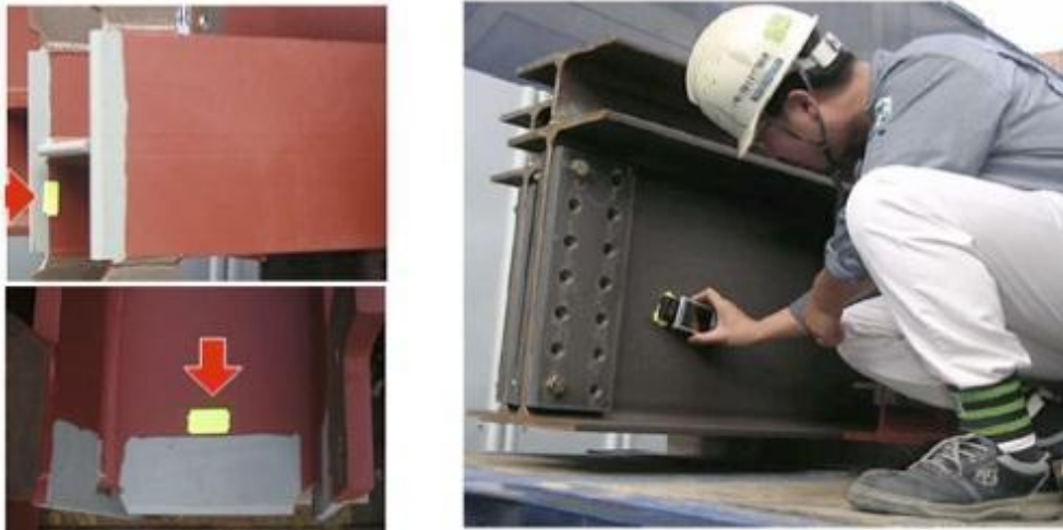
Figura 4- RFID tag na construção
