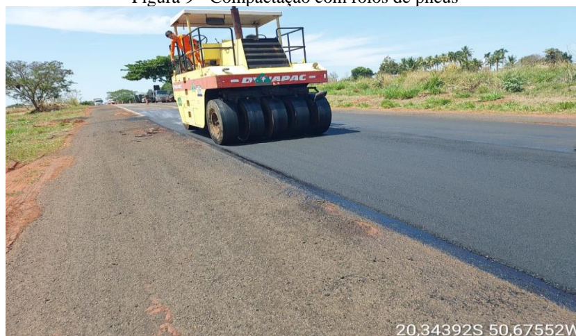
Figura 9 - Compactação com rolos de pneus
