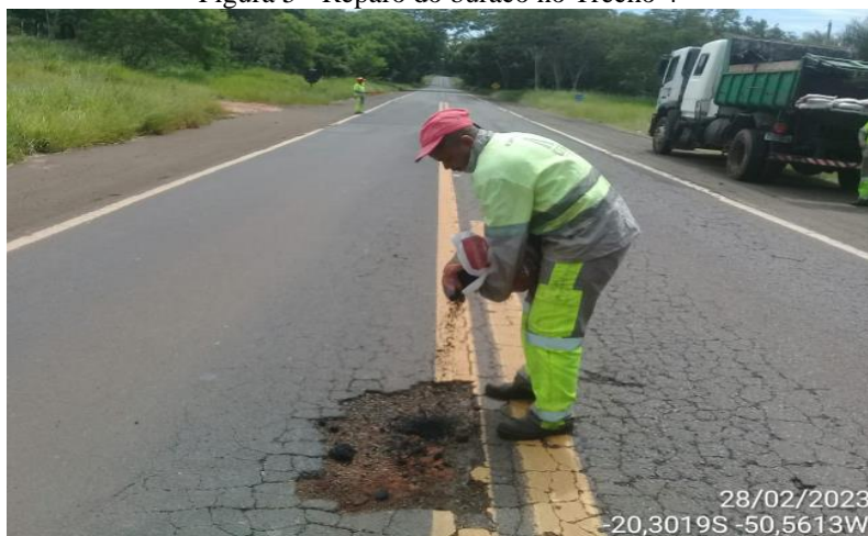
Figura 5 - Reparo do buraco no Trecho 4
