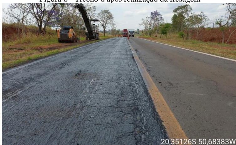
Figura 8 - Trecho 6 após realização da fresagem
