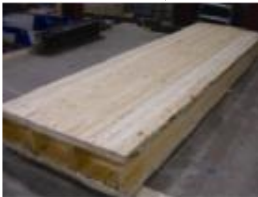
Figura 4 – Sistema canadense inovador, CLT em formato de caixa
