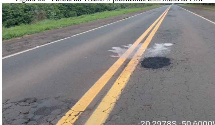
Figura 22 - Panela do Trecho 5 preenchida com material PMF
