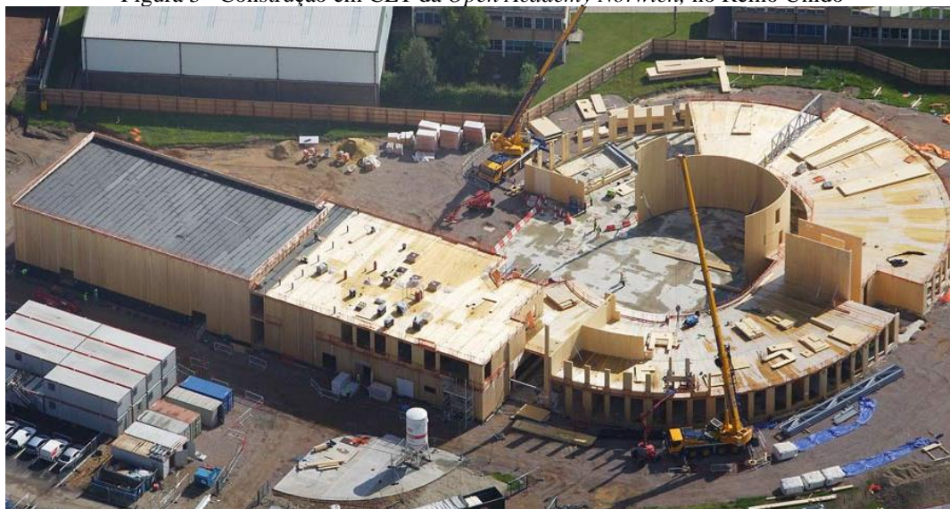
Figura 3– Construção em CLT da Open Academy Norwich , no Reino Unido
