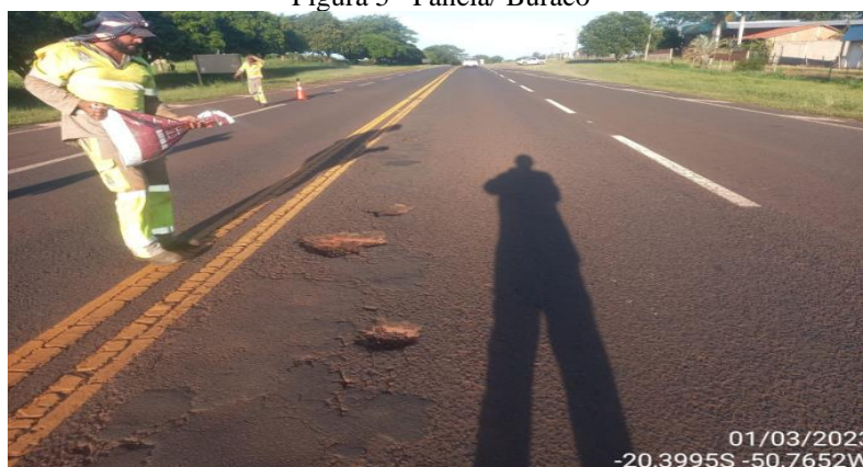
Figura 5– Panela/ Buraco
