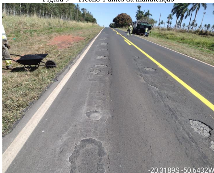
Figura 9 – Trecho 1 antes da manutenção
