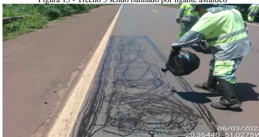
Figura 15 - Trecho 3 sendo banhado por ligante asfáltico
