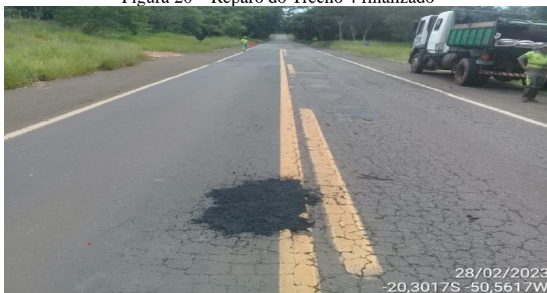
Figura 20 - Reparo do Trecho 4 finalizado
