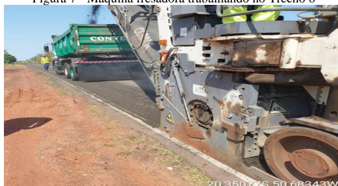
Figura 7 - Máquina fresadora trabalhando no Trecho 6
