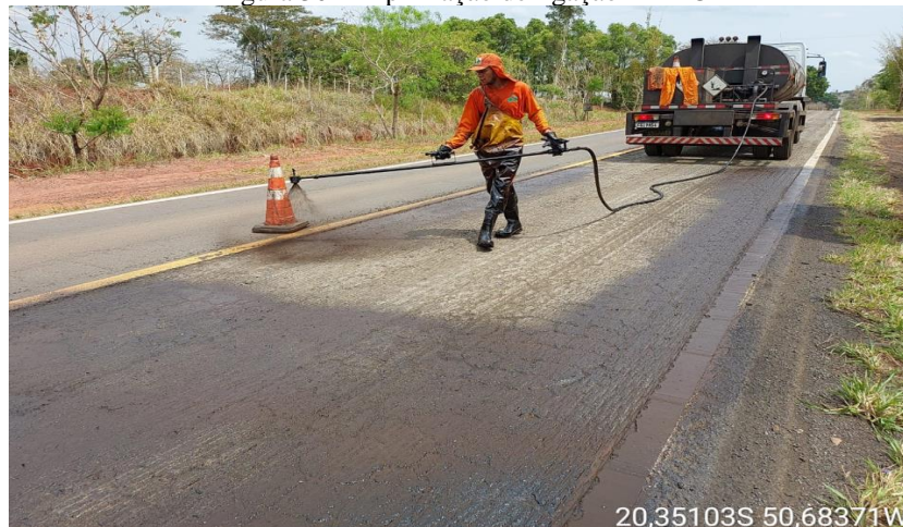
Figura 30 - Imprimação de ligação RR-2C
