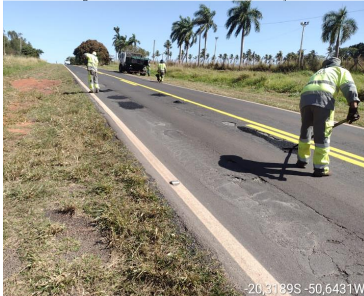
Figura 10 – Trecho 1 durante a manutenção
