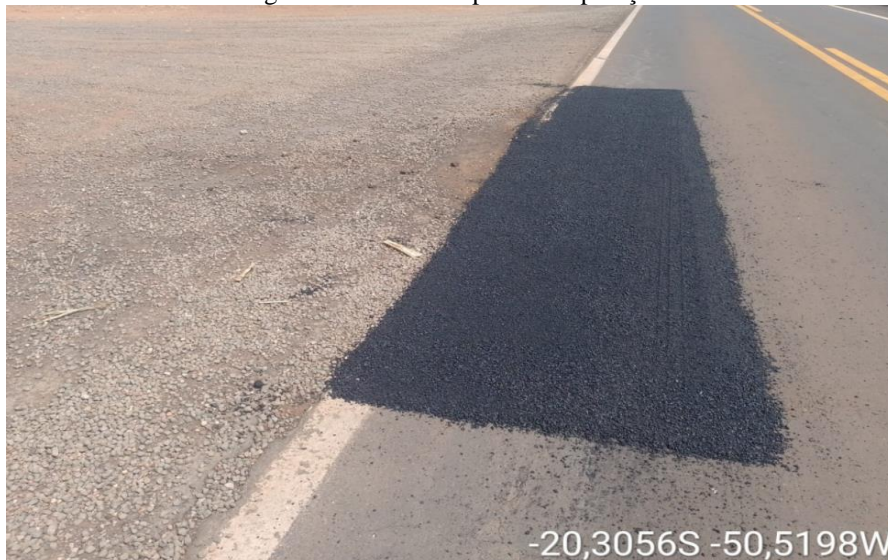
Figura 4 – Trecho 2 após a recuperação
