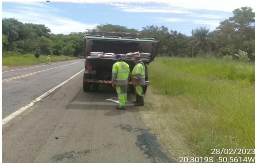
Figura 17- Sacos do material PMF dentro do caminhão
