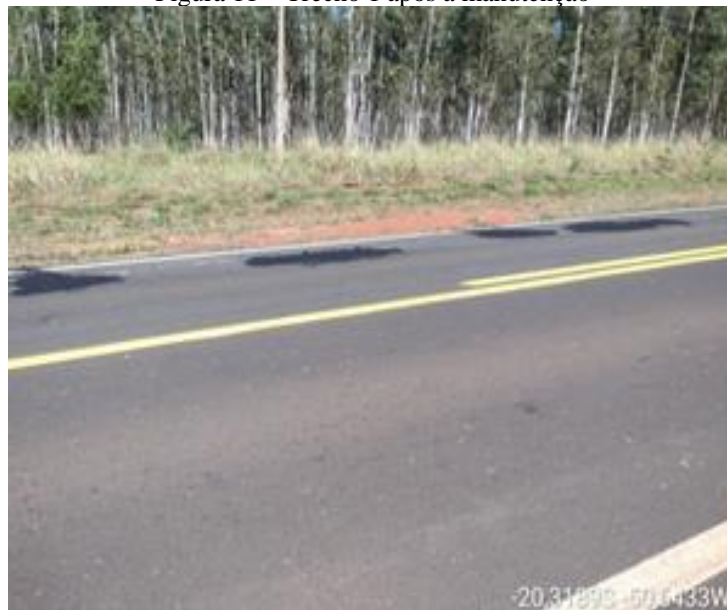
Figura 11 – Trecho 1 após a manutenção
