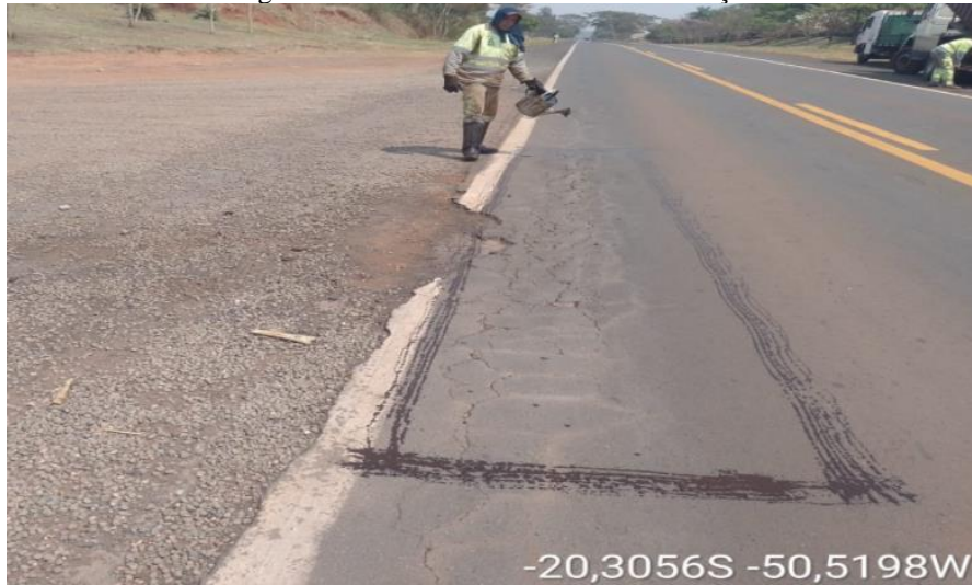
Figura 123 – Trecho 2 durante a manutenção
