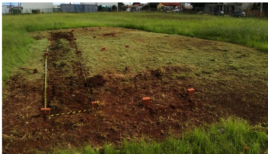
Figura 4 - Marcação dos canteiros
