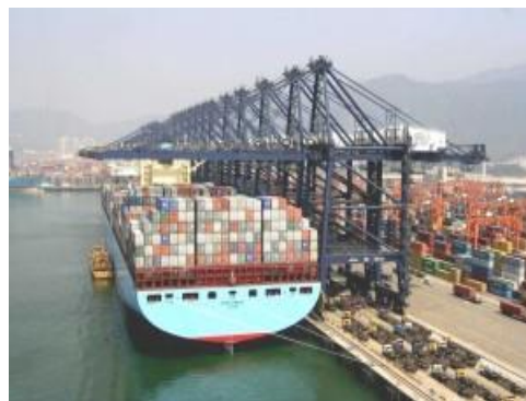
Operação de contêineres Porto de Rotterdam- Holanda
