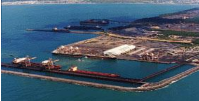
Figura 8 Porto de Tubarão
