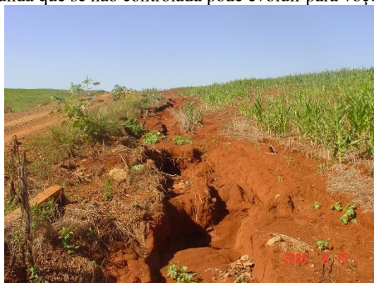
Figura 49. Foto de ravina profunda que se não controlada pode evoluir para voçorocamento. (Campos, R. 2006)
