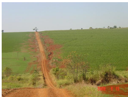
Figura 48. Foto de área com profundas feições erosivas à margem da estrada. (Campos, R. 2006)
