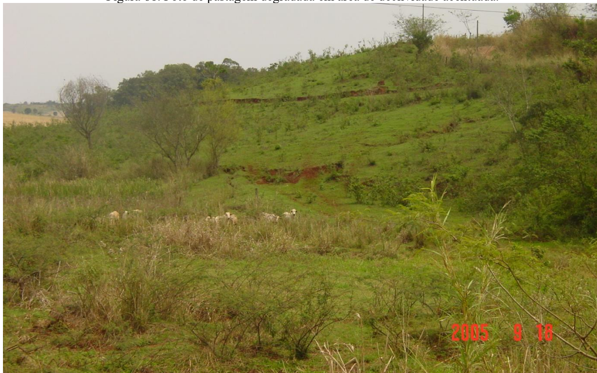
Figura 61. Foto de pastagem degradada em área de declividade acentuada.
