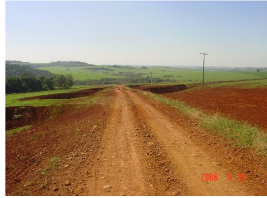
Figura 43. Foto de murunduns usados para tentar conter a erosão próxima as estradas rurais. (Campos, R. 2006)
