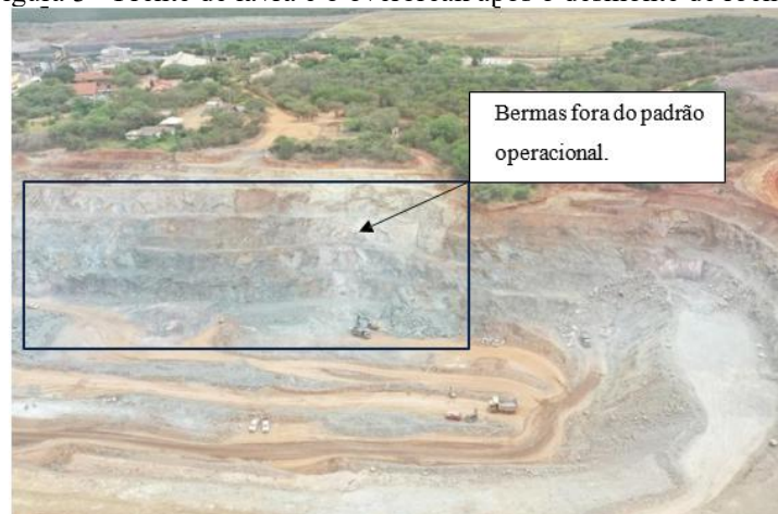
Figura 3 - Frente de lavra e o overbreak após o desmonte de rochas.
