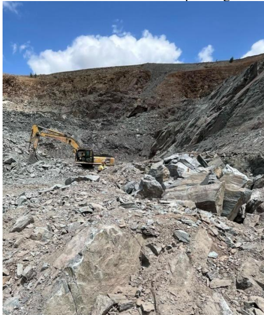
Figura 13 - Escavadeira realizando repé e regularizações.
