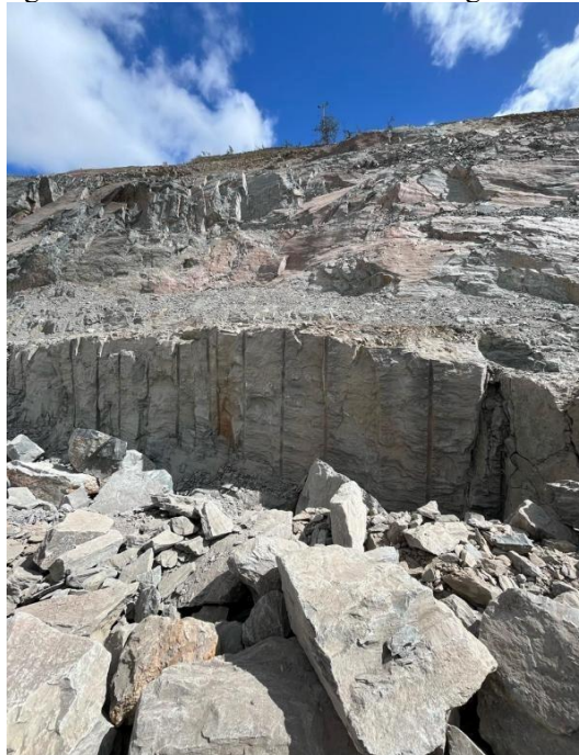
Figura 12 - Pré-corte com material fragmentado.
