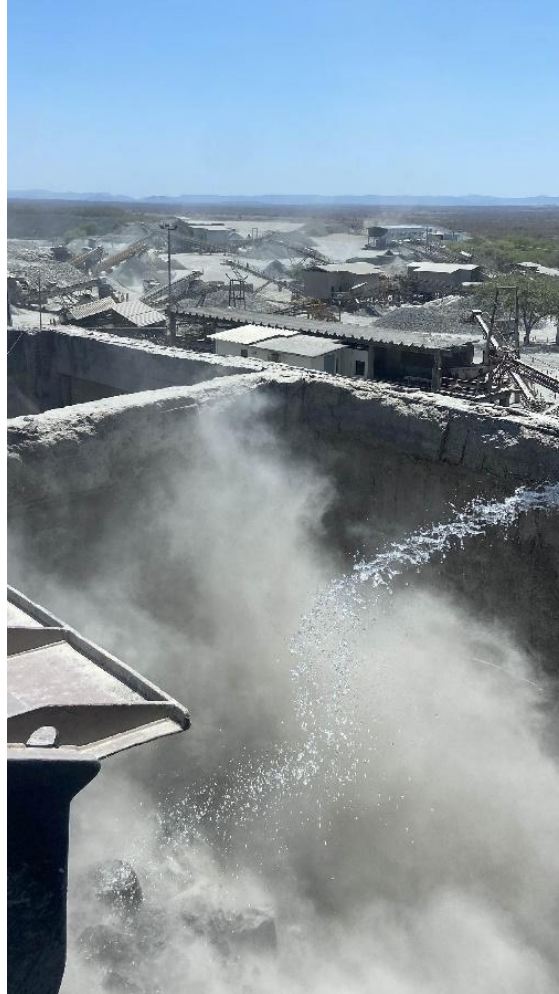
Figura 8: Alimentação da Britagem Primária (BR200).
