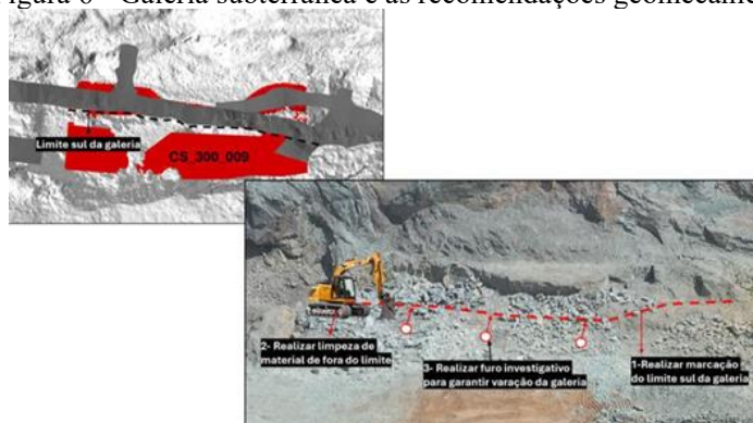
Figura 6 - Galeria subterrânea e as recomendações geomecânica.
