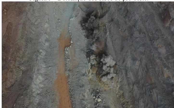
Figura 9 - Detonação dos furos de pré-corte.
