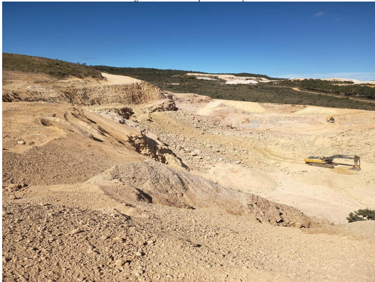
Figura 3 - Bancada após a detonação
